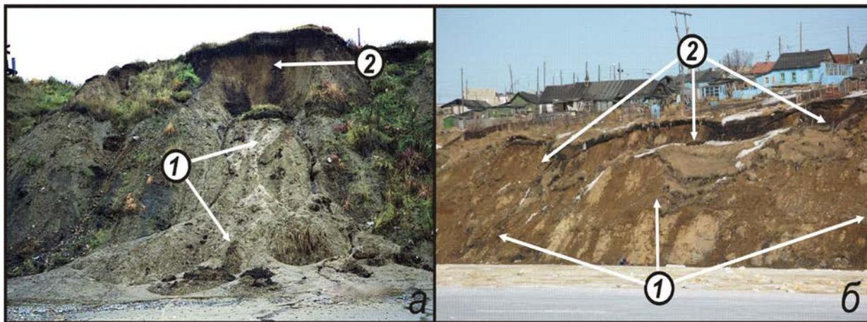
**Рис. 28.** Два из семи обвалов и оползней, сошедших с Восточного клифа бух. Нагаева за период с 2002 по 2010 гг.: а – обвал-оползень НК-0,00075 – объемом около 750 м<sup>3</sup>, образовавшийся в октябре 2003 г.; б – оползень НК-0,014 объемом около 14 000 м<sup>3</sup>, возникший осенью 2006 г. 1 – тело оползня; 2 – ниша отрыва. Эти оползни, как и многие другие, уже размыты прибоем, и их материал перенесен на морское дно.
