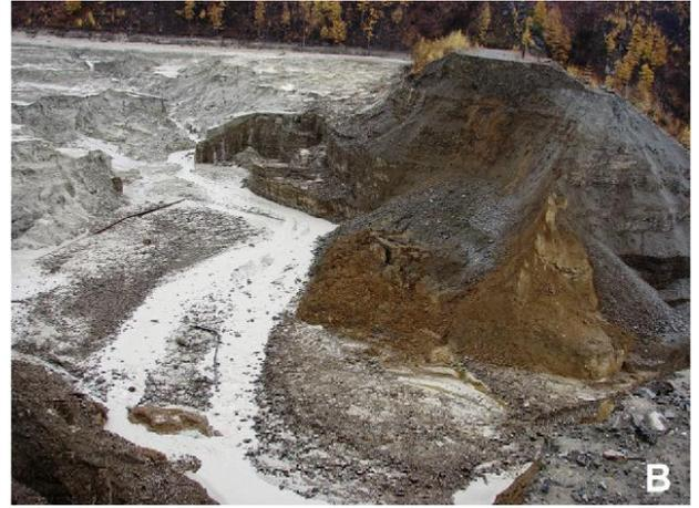
**Рис. 7.** Катастрофический прорыв жидкой массы грунтов дамбы и хвостов: А – Водные потоки в водохранилищах, образующие промоины в осажденной пульпе, после прорыва дамбы (ситуация на 30.09.2009 г. 12:00); В – хвостохранилище после прорыва дамбы с разрезом отложений пульпы
